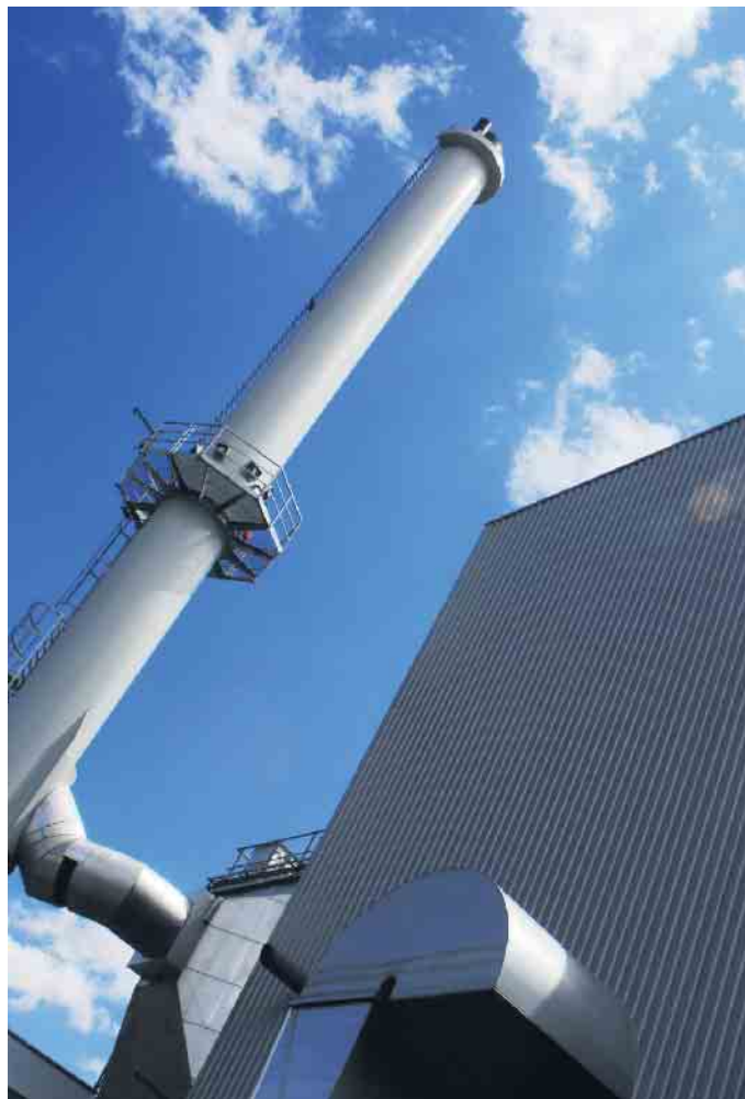
Hocheffiziente Holzheizkraftwerke können den Ausbau der Fernwärmeversorgung ermöglichen. Foto: DJD/Bundesverband Bioenergie
