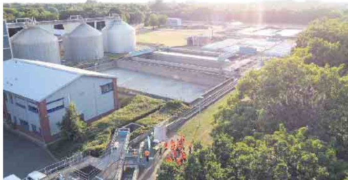
Gruppenklärwerk Bergheim-Kenten. Fotos: Erftverband
